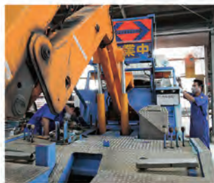
▲作業は塗装用防塵マスクをつけて
